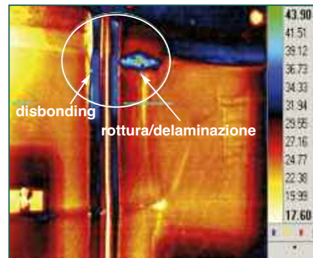
Figura 14 - Termogramma in fase (0.1 Hz); termocamera IR e modulo Lock-in
